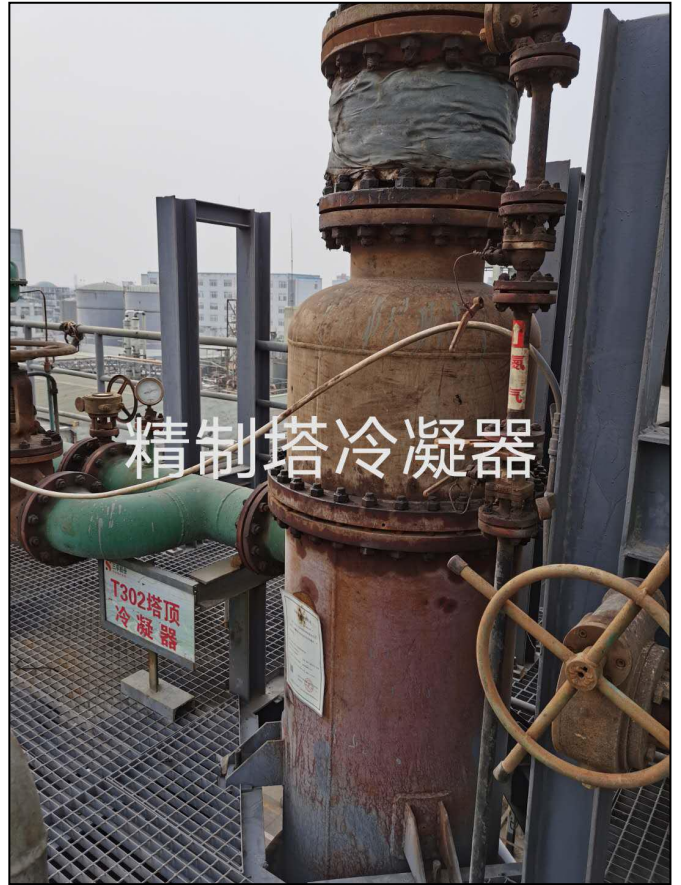
精制塔冷凝器
